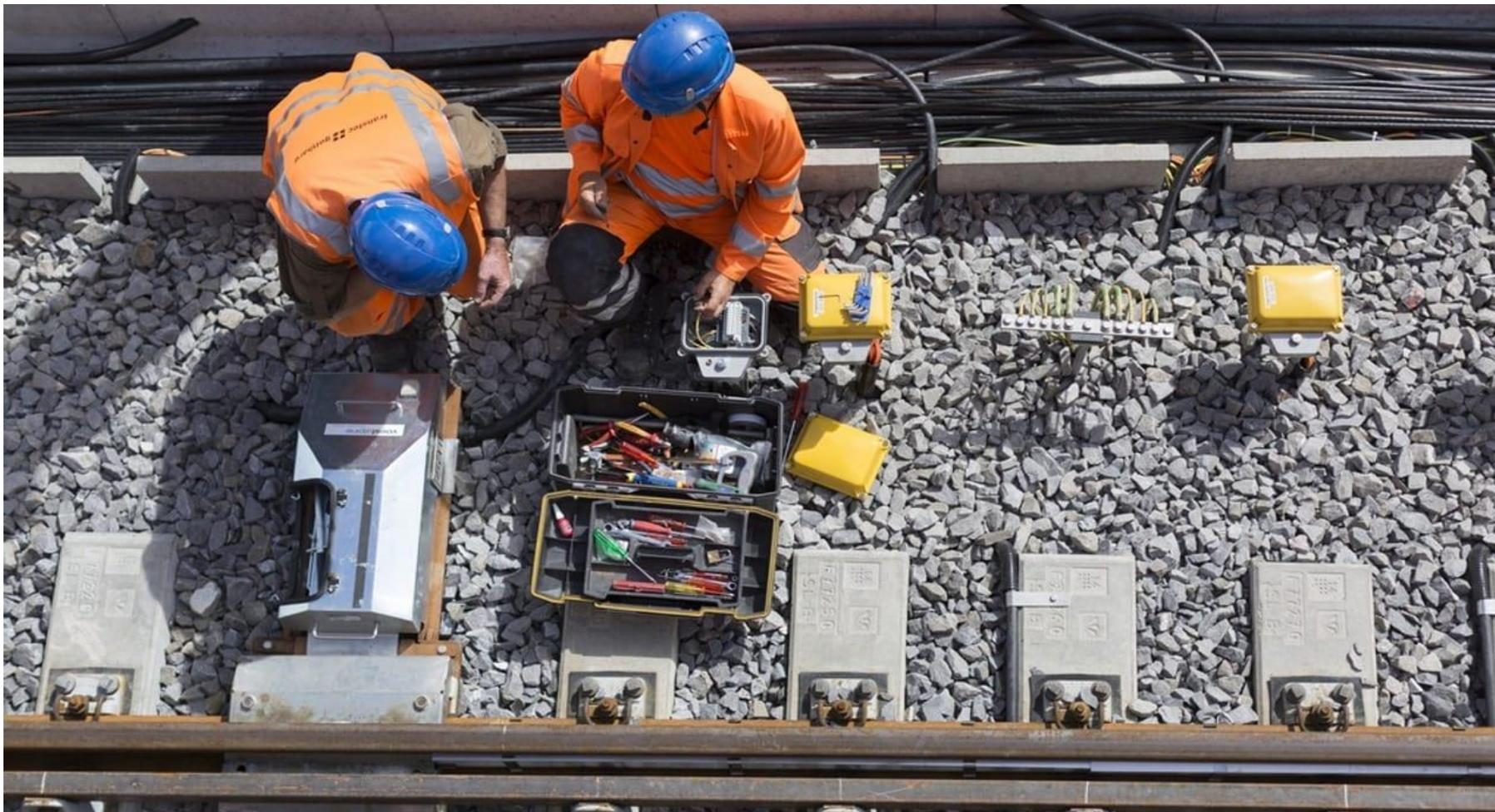
Montage d'un chauffage d'aiguillage
